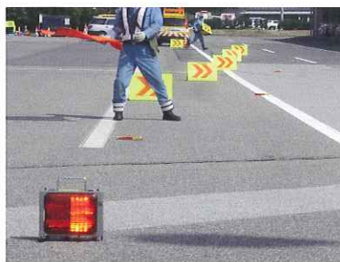
■ 予告テーパー設置箇所
