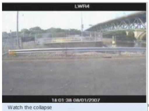
ミネソタの橋梁崩落事故 2007. 8.1
