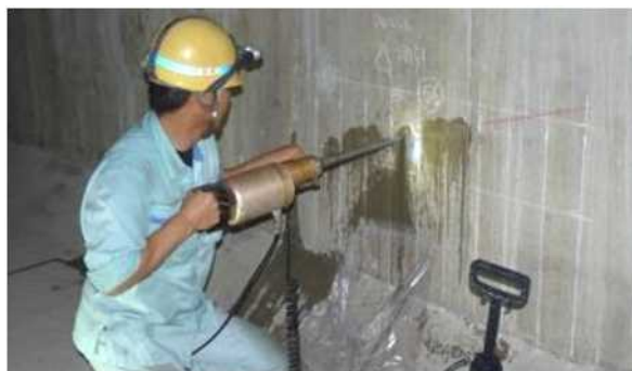
超音波ドリルによる削孔
