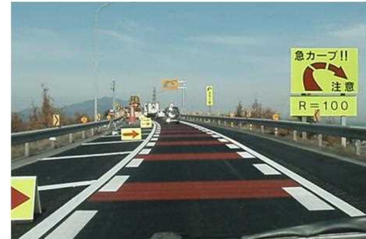
【薄層舗装・導流レーンマーク・注意喚起標識】
