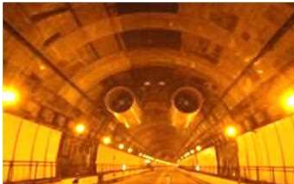
天井板を撤去しジェットファン設置
