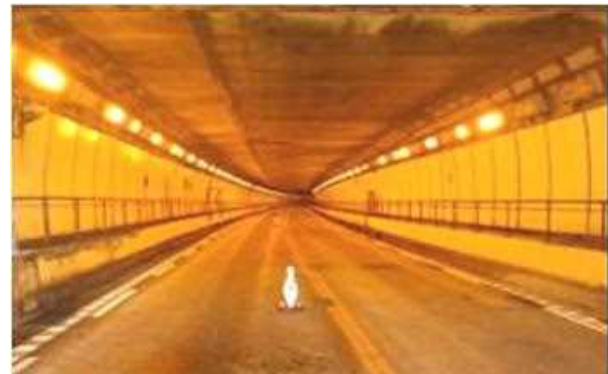
恵那山トンネル(天井板撤去前)
