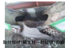
取付部材(横支材・下横構)の損傷
