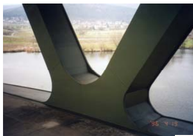
繊細な配慮 水処理
