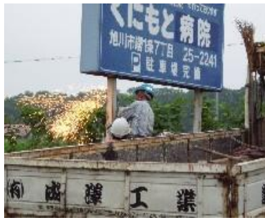
支障物件(看板)の撤去
